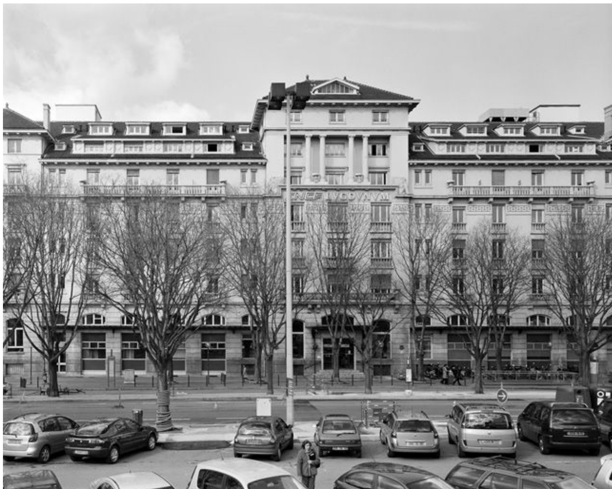
Elévation antérieure : vue partielle
