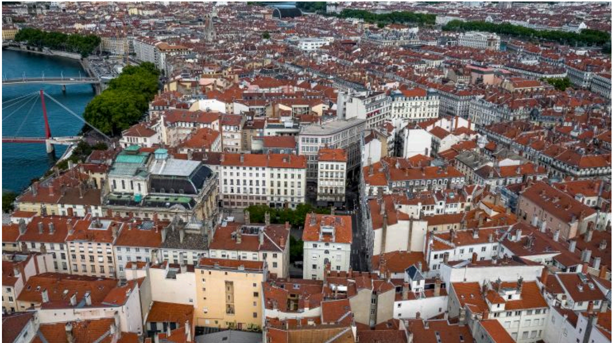
Vue aérienne prise au droit de la place Bellecour vers le nord
