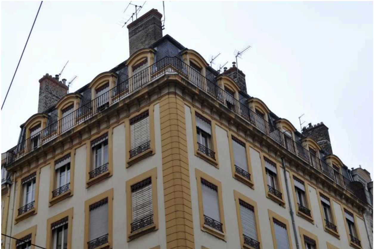
Détail du dernier étage depuis le nord-ouest
