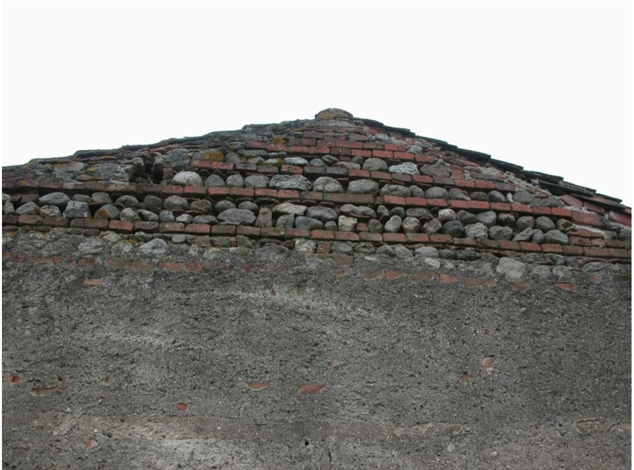
Détail du pignon de la ferme voisine, avec des rangs de brique provenant peut-être de la production de l'ancienne tuilerie.
