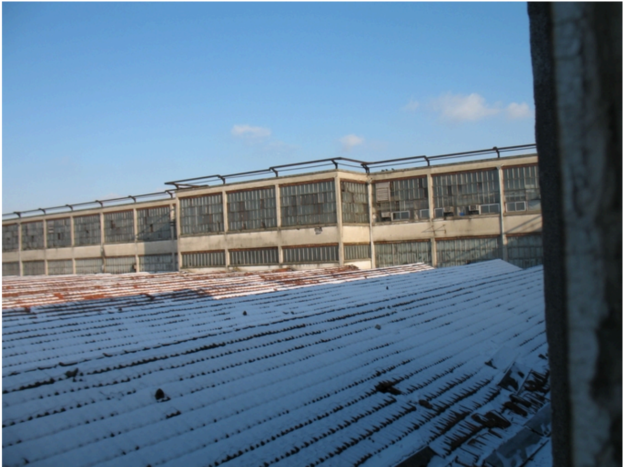
Vue d'ensemble des toits
