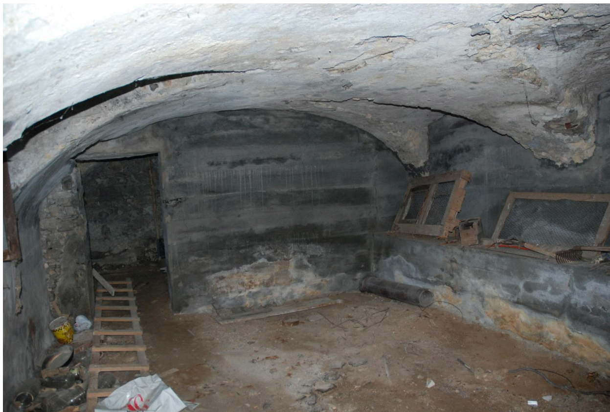
Vue intérieure de la cave sud-est.
