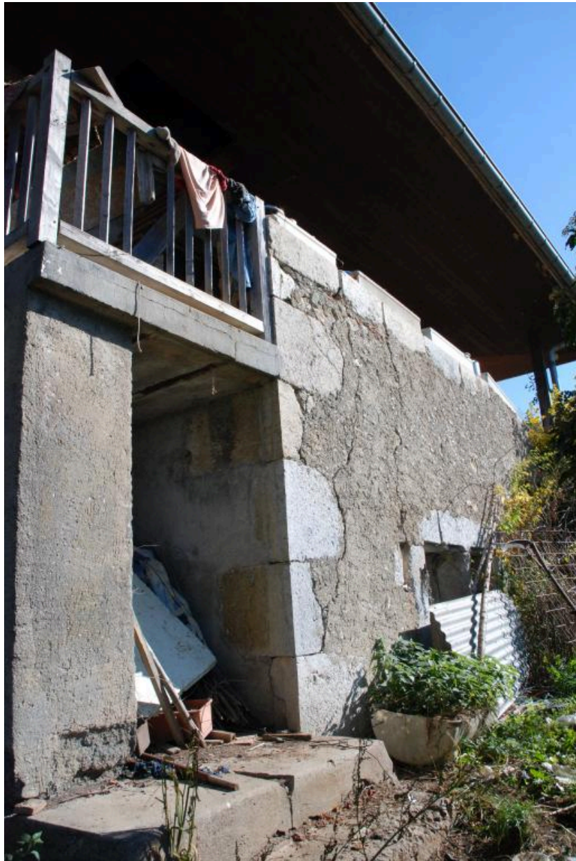
Vue arrière du massif supportant la montée d'escalier extérieure
