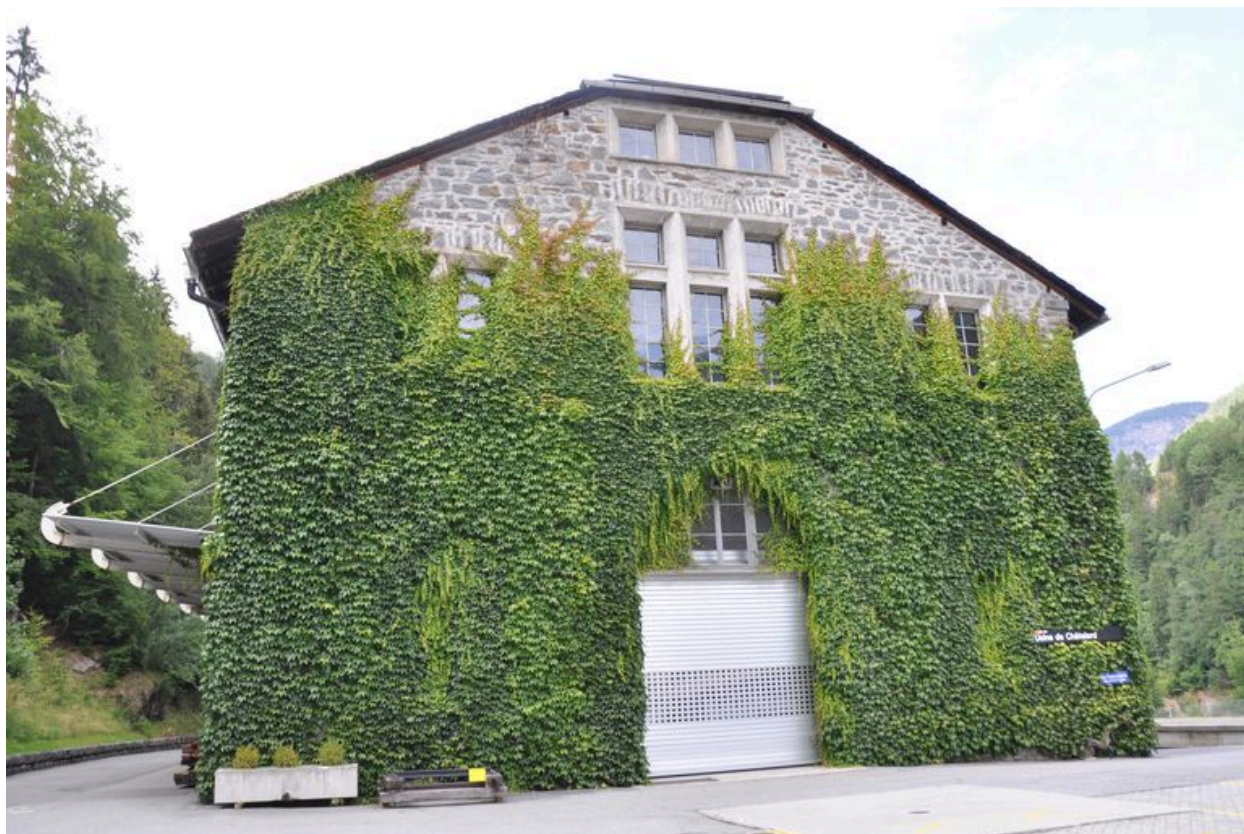
Mur pignon sud-ouest de l'usine CFF du Châtelard
