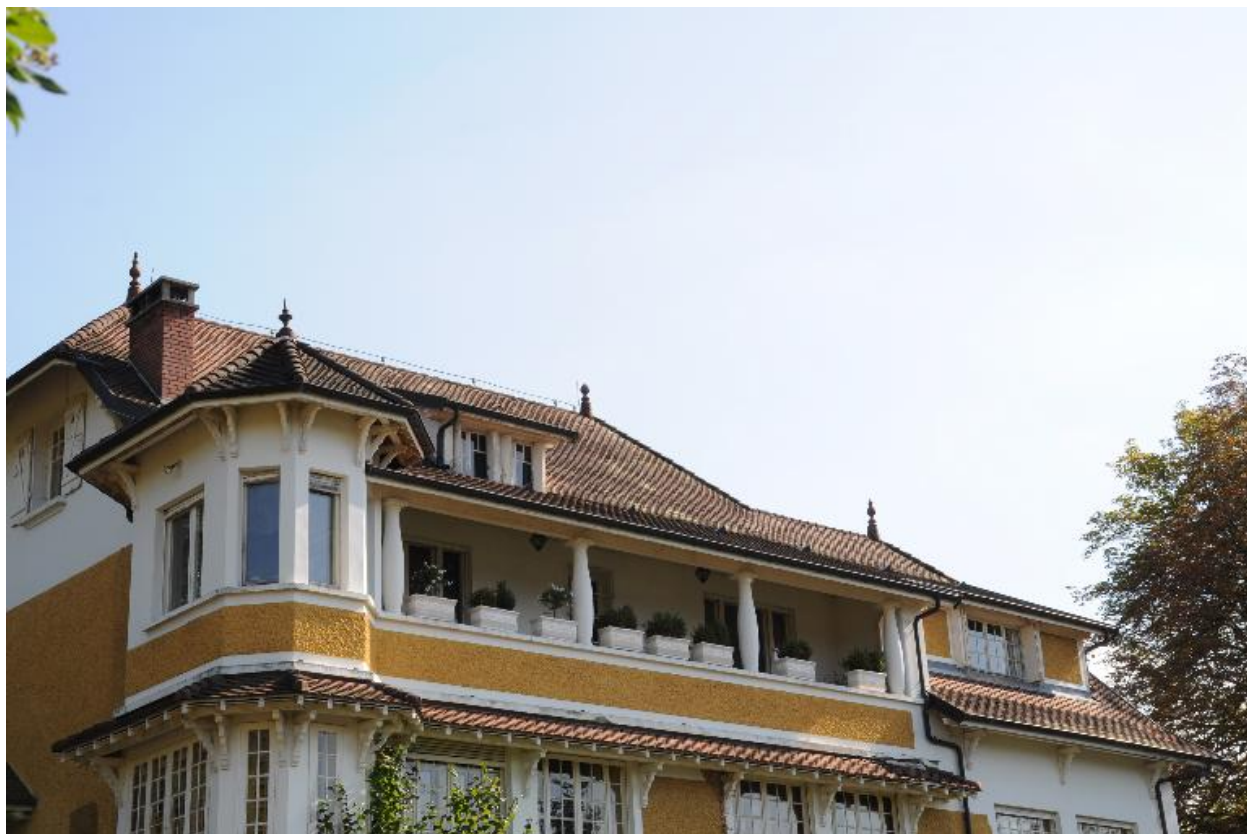
Galerie loggia sur la façade principale (ouest)
