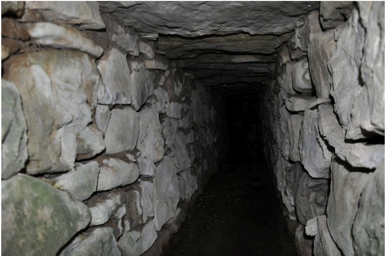
Vue intérieure du canal de fuite
