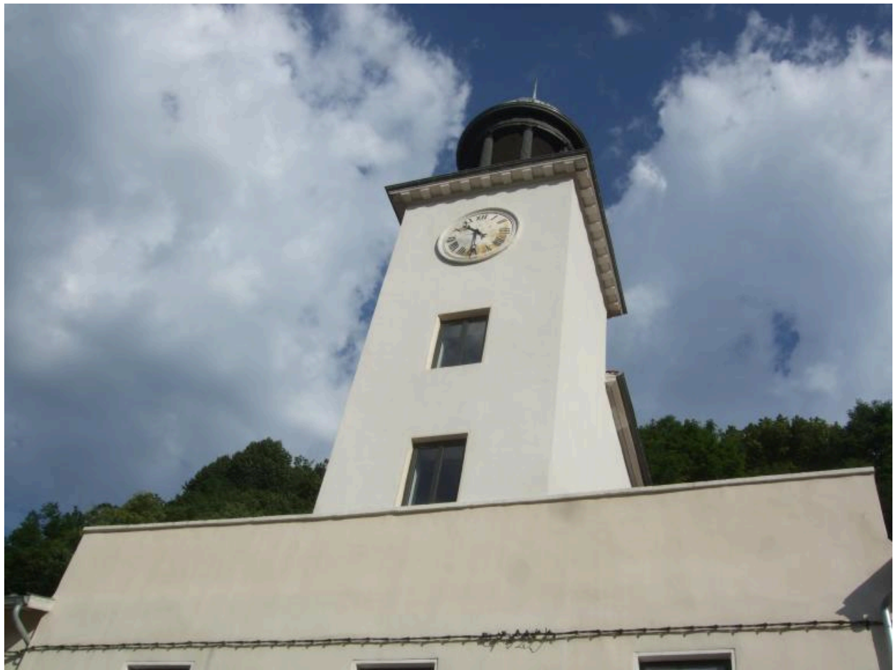
Détail tour horloge.
