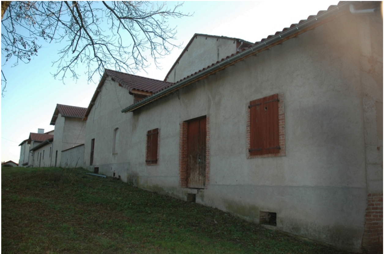
Vue arrière, depuis le nord.
