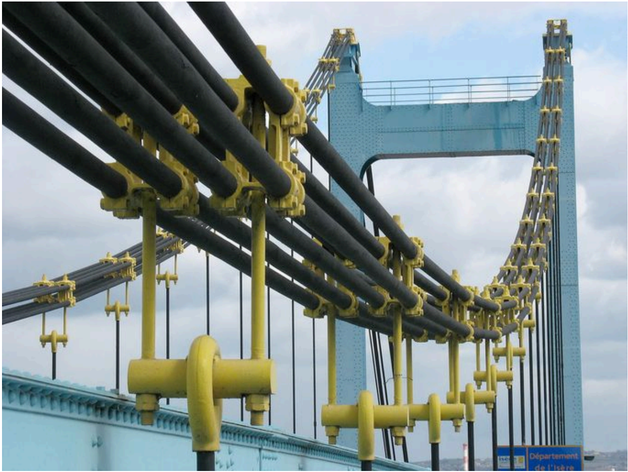
Vue de câbles de retenue et suspentes
