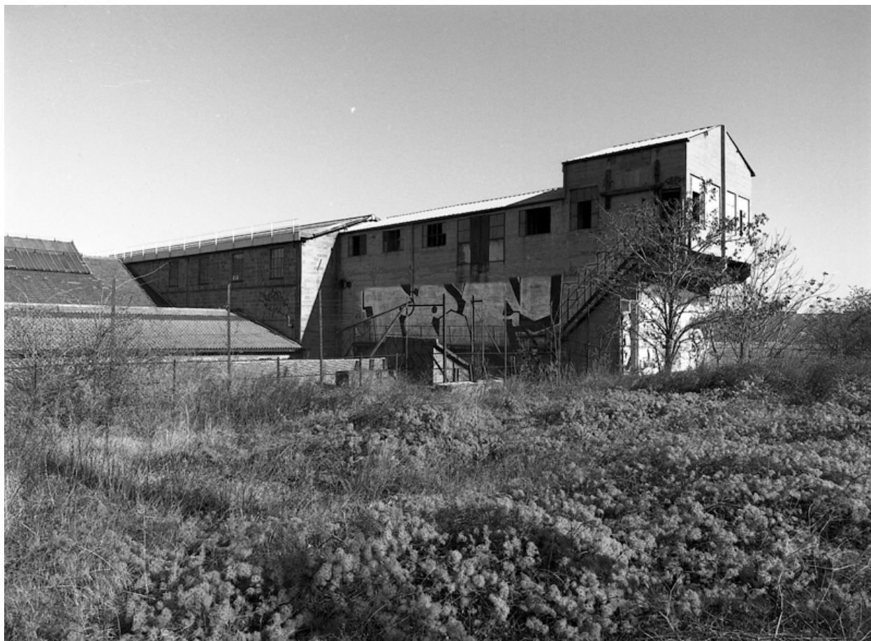
Bâtiments industriels en 2005, avant destruction.
