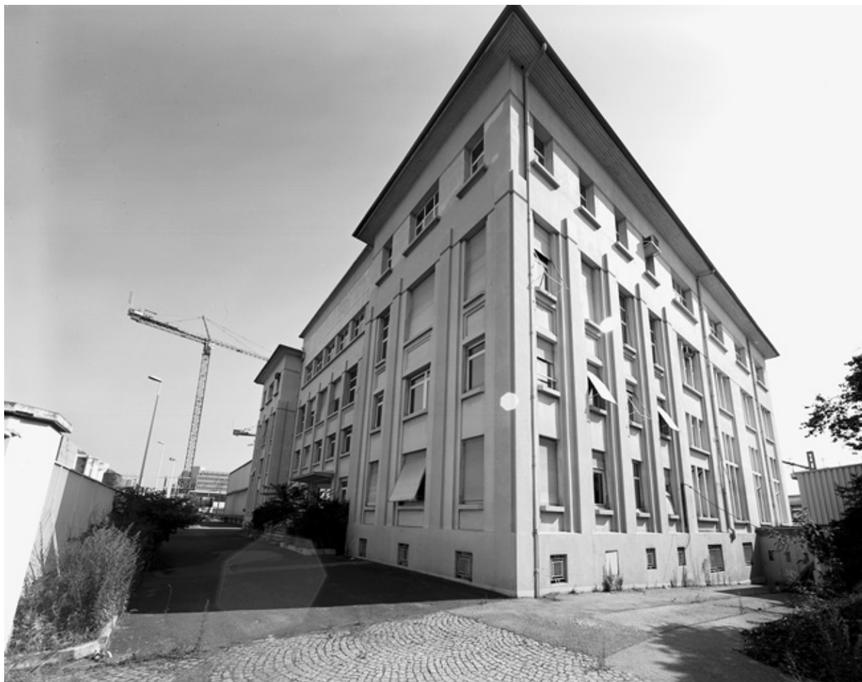
Vue générale sud-ouest du bâtiment principal
