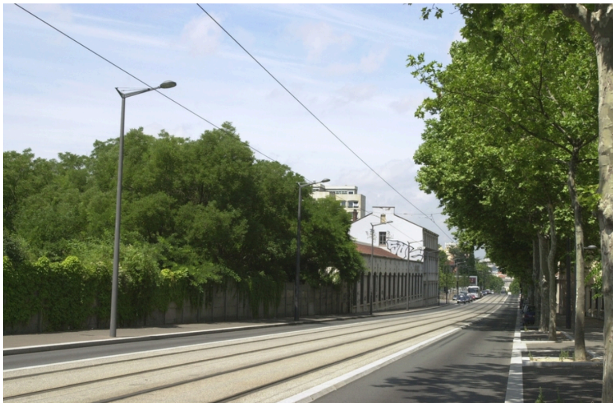
Façade est-ouest, avenue Rockefeller
