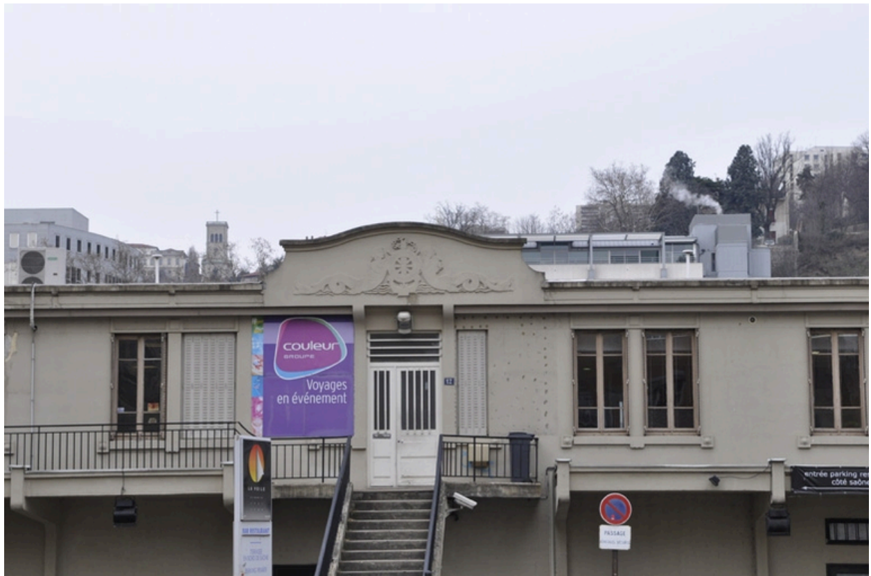
Entrée principale, vue est
