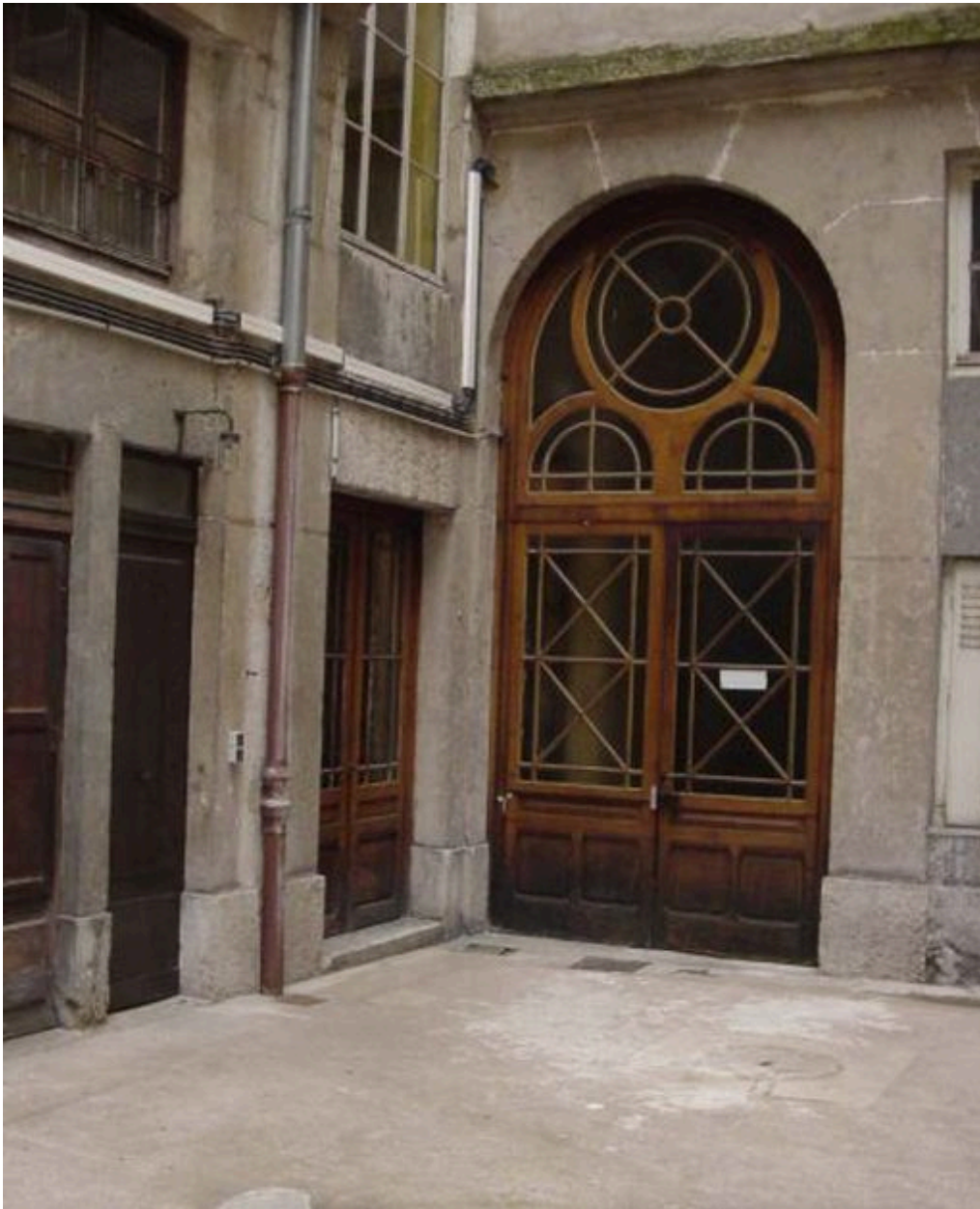
Porte donnant accès au vestibule d'entrée depuis la cour
