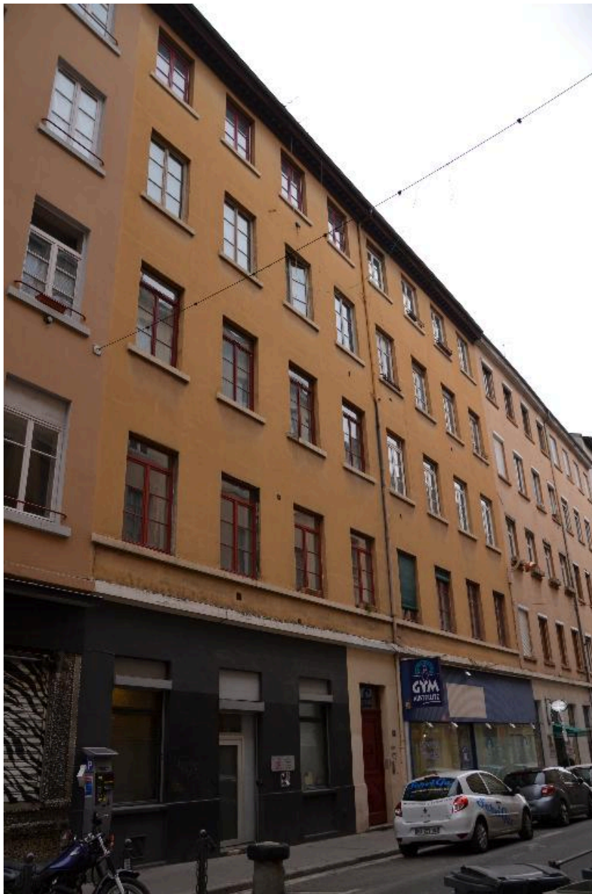
Vue d'ensemble façade sud
