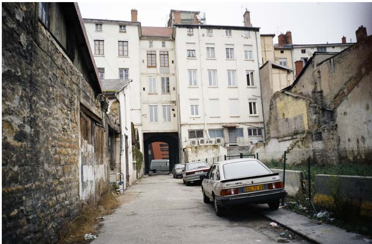
Vue générale ouest
