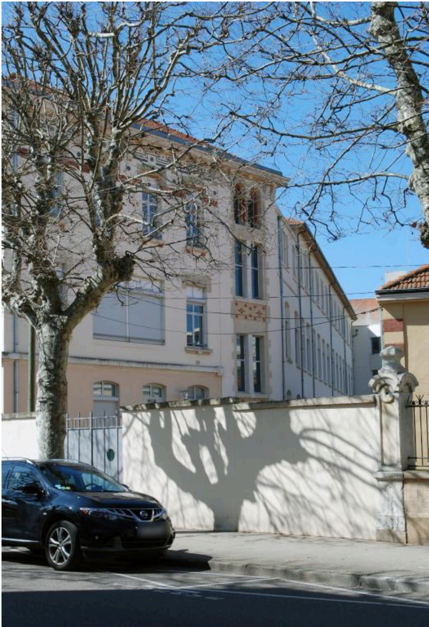
Elévation latérale nord, depuis l'ouest
