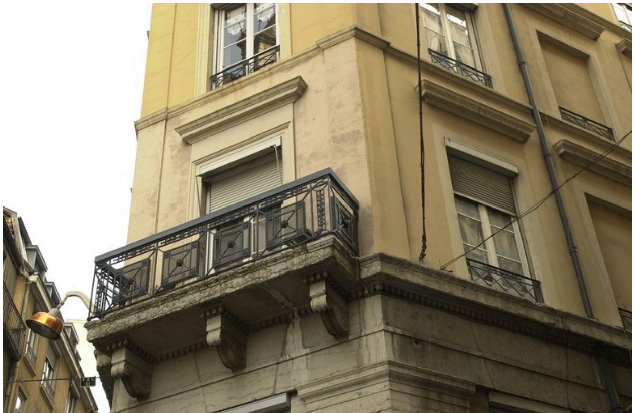
Traitement de l'angle : détail du balcon
