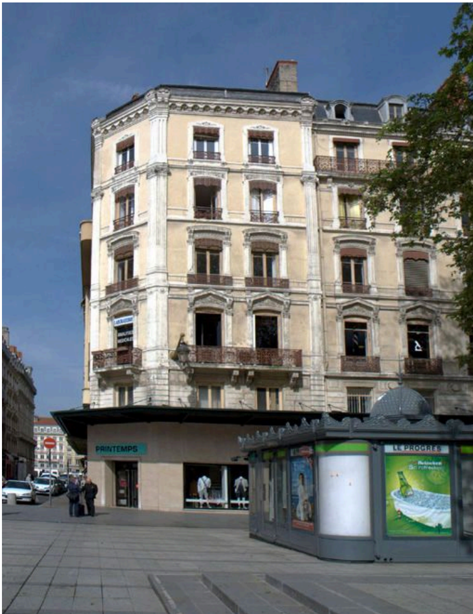
Vue de l'angle sud-est
