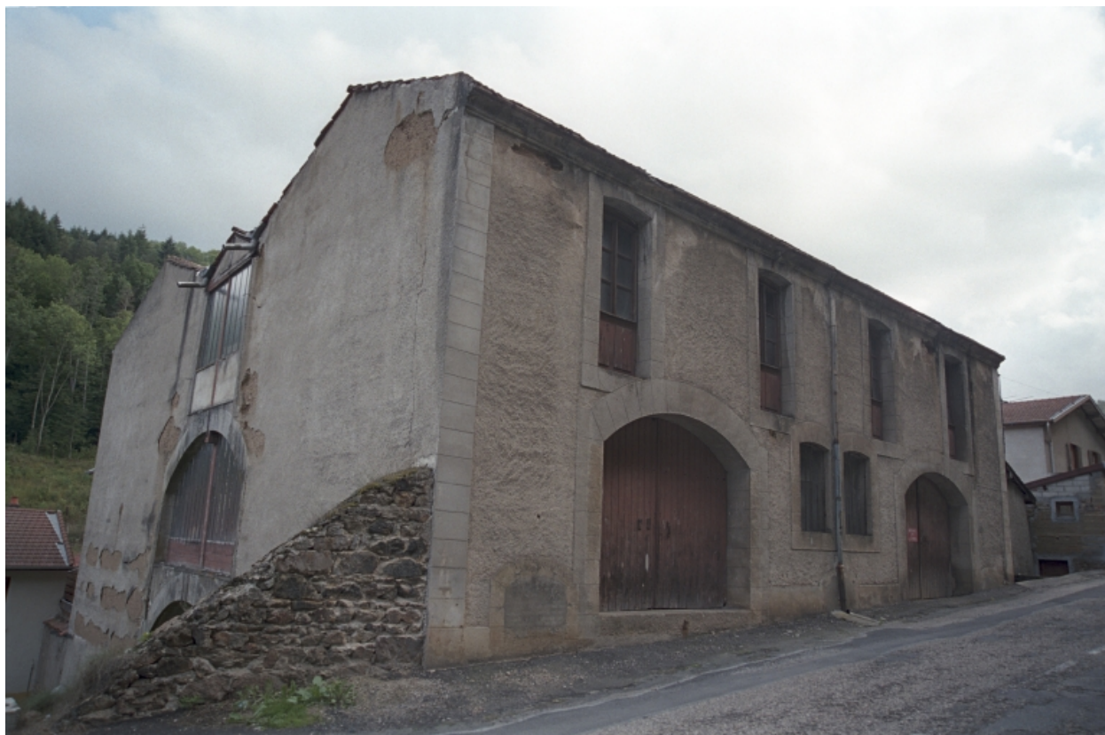
Dépôt des bouteilles, vue d'ensemble de l'élévation arrière, avec quai de chargement.
