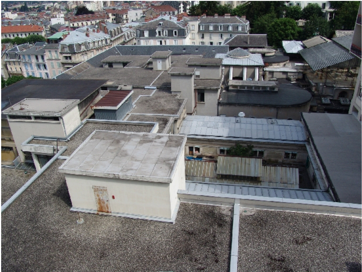
Vue des toits : partie nord-ouest
