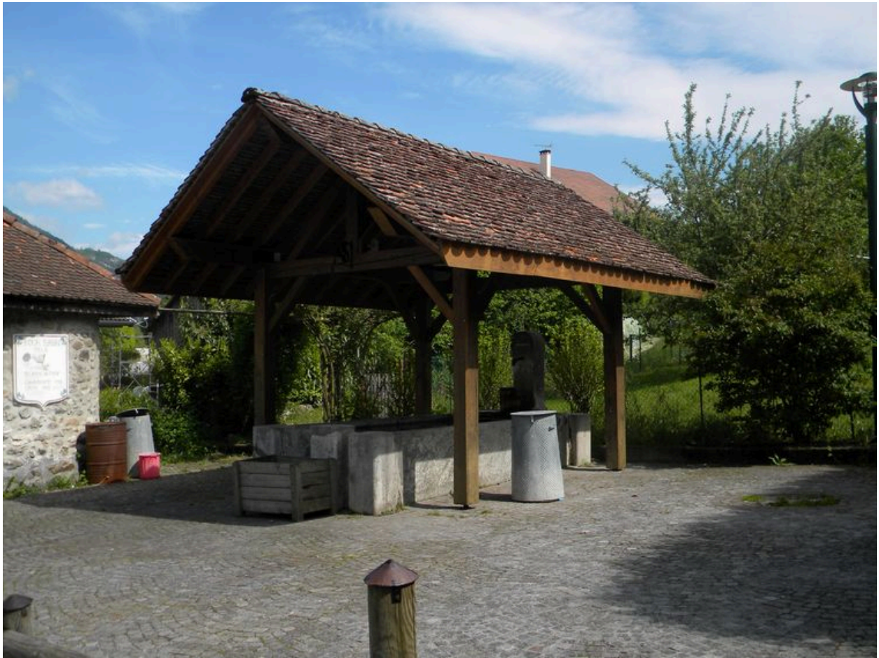
Vue générale du bassin couvert.
