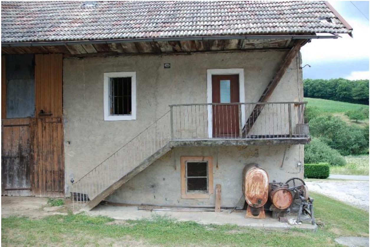
Détail du bâtiment nord : habitation.
