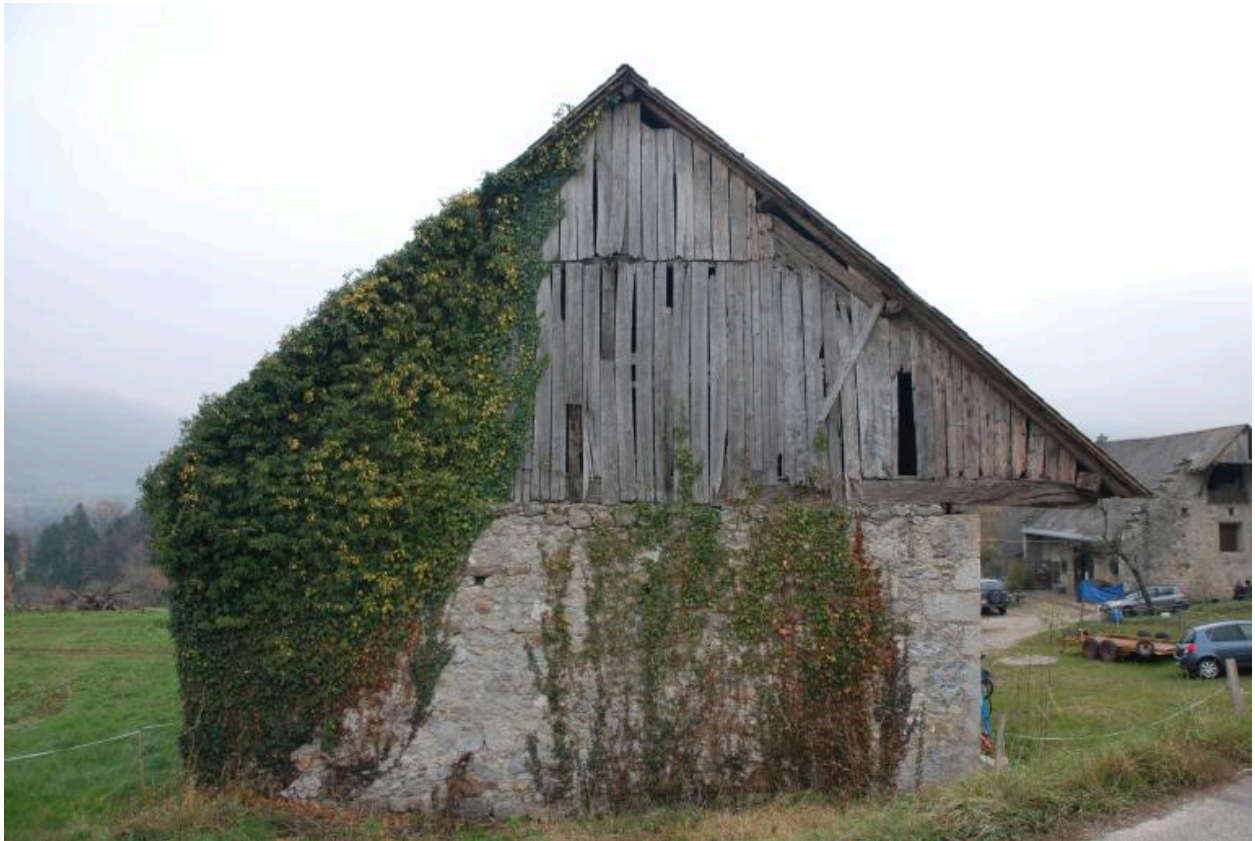
Vue du mur pignon nord.
