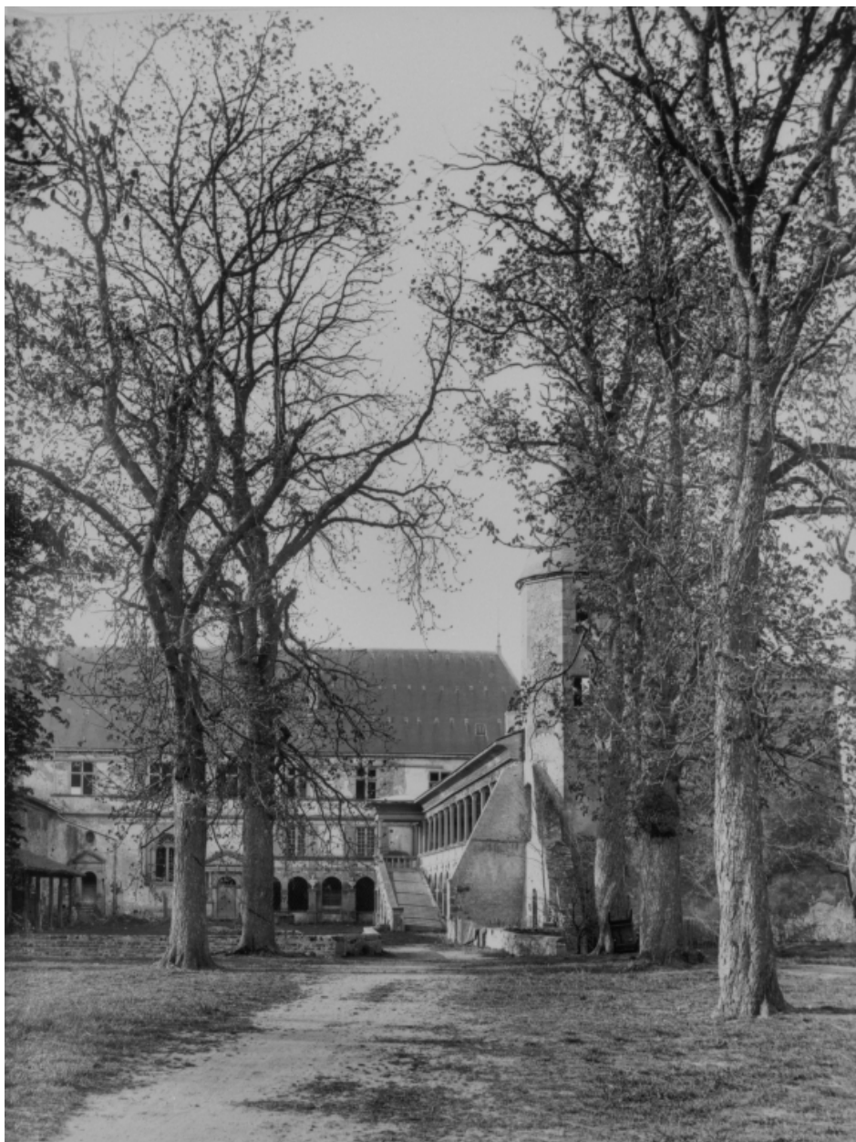
Vue générale du corps de logis depuis le portail, au nord, vers 1914 ?
