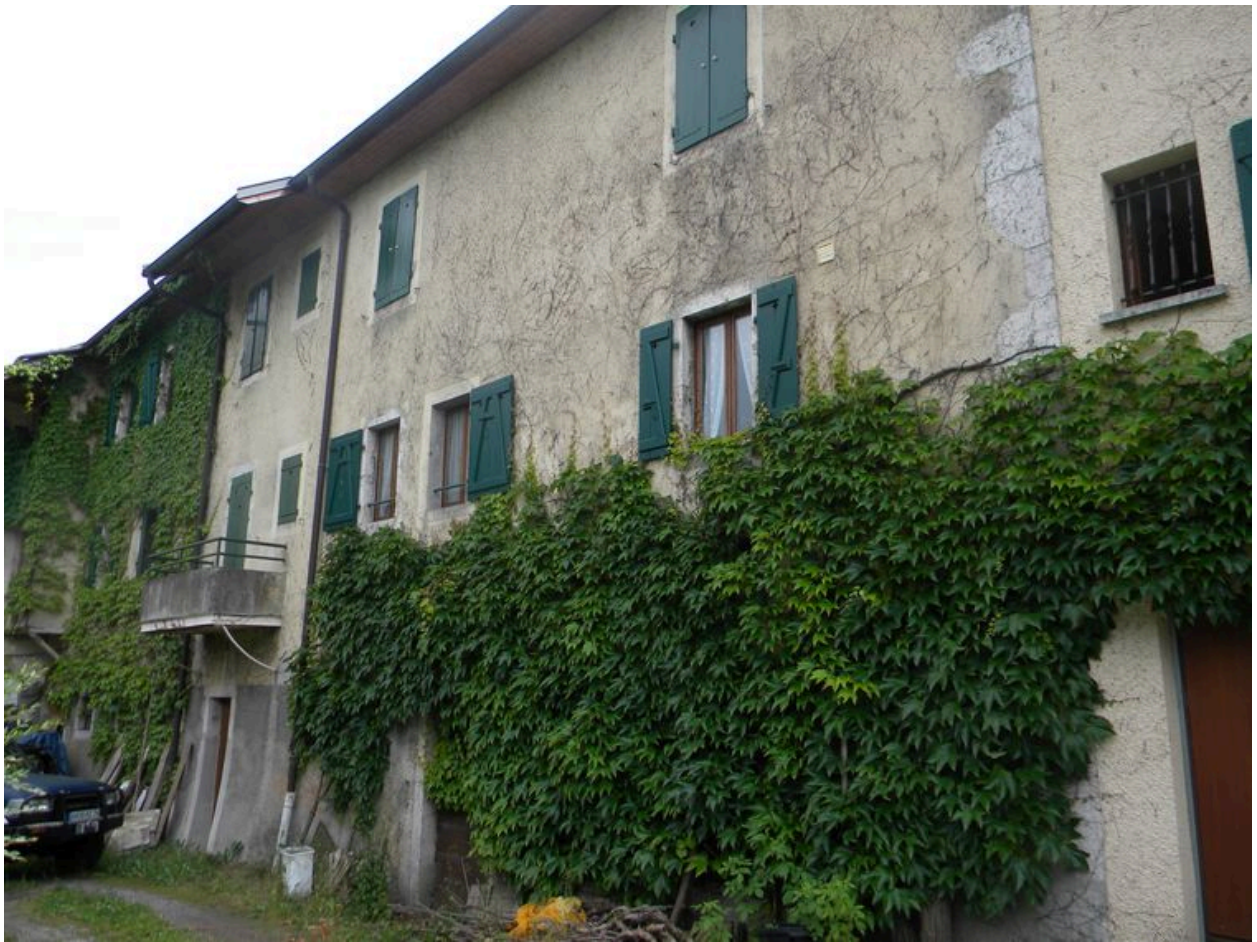
Vue de la façade arrière depuis l'ouest.
