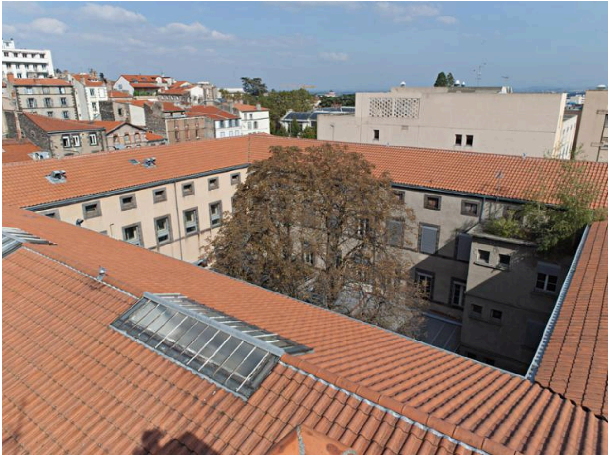
Hôtel-Dieu de Clermont-Ferrand. Le Refuge, les toits et la cour intérieure vus du sud-ouest.
