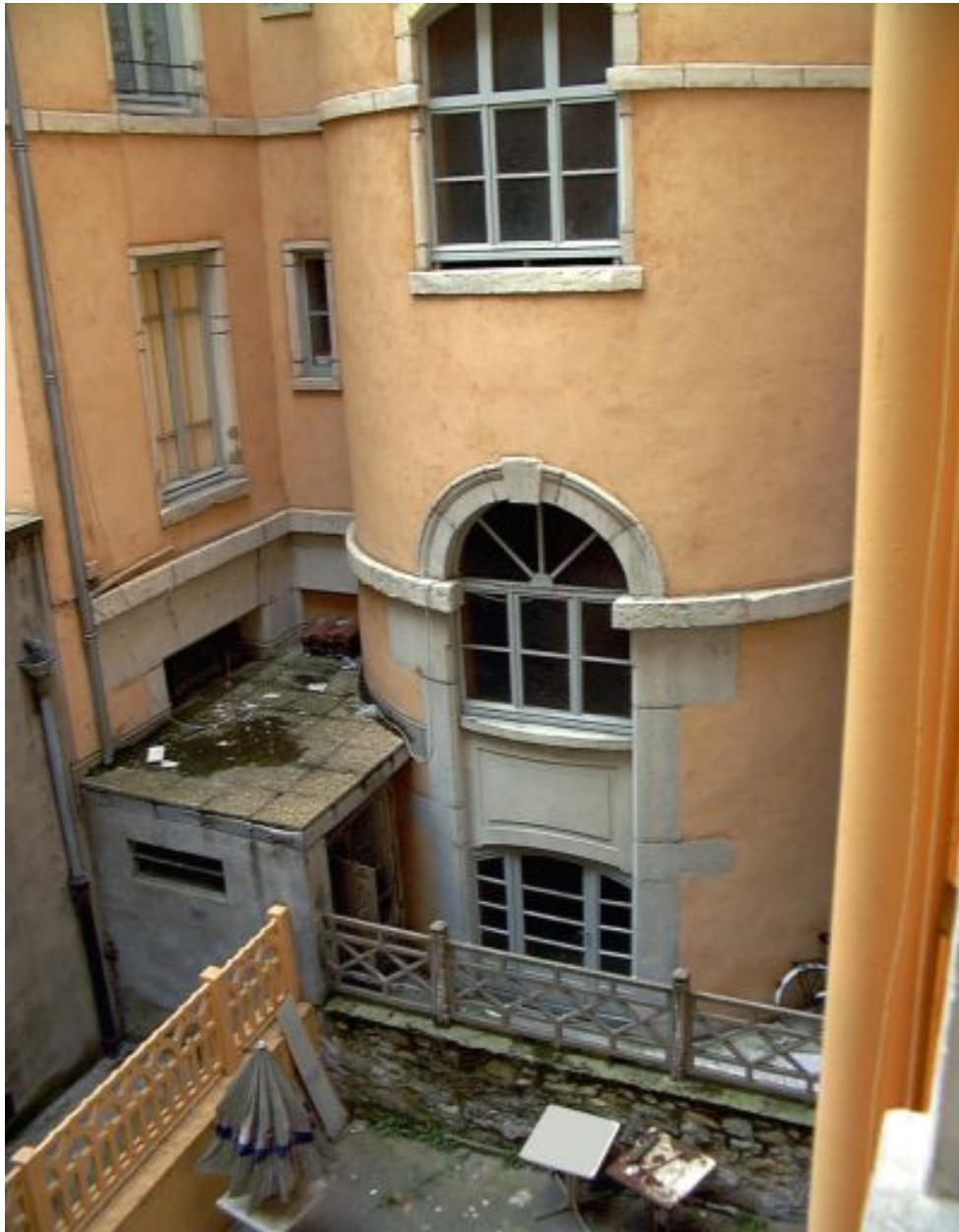
Vue du rez-de-chaussée de la tour d'escalier
