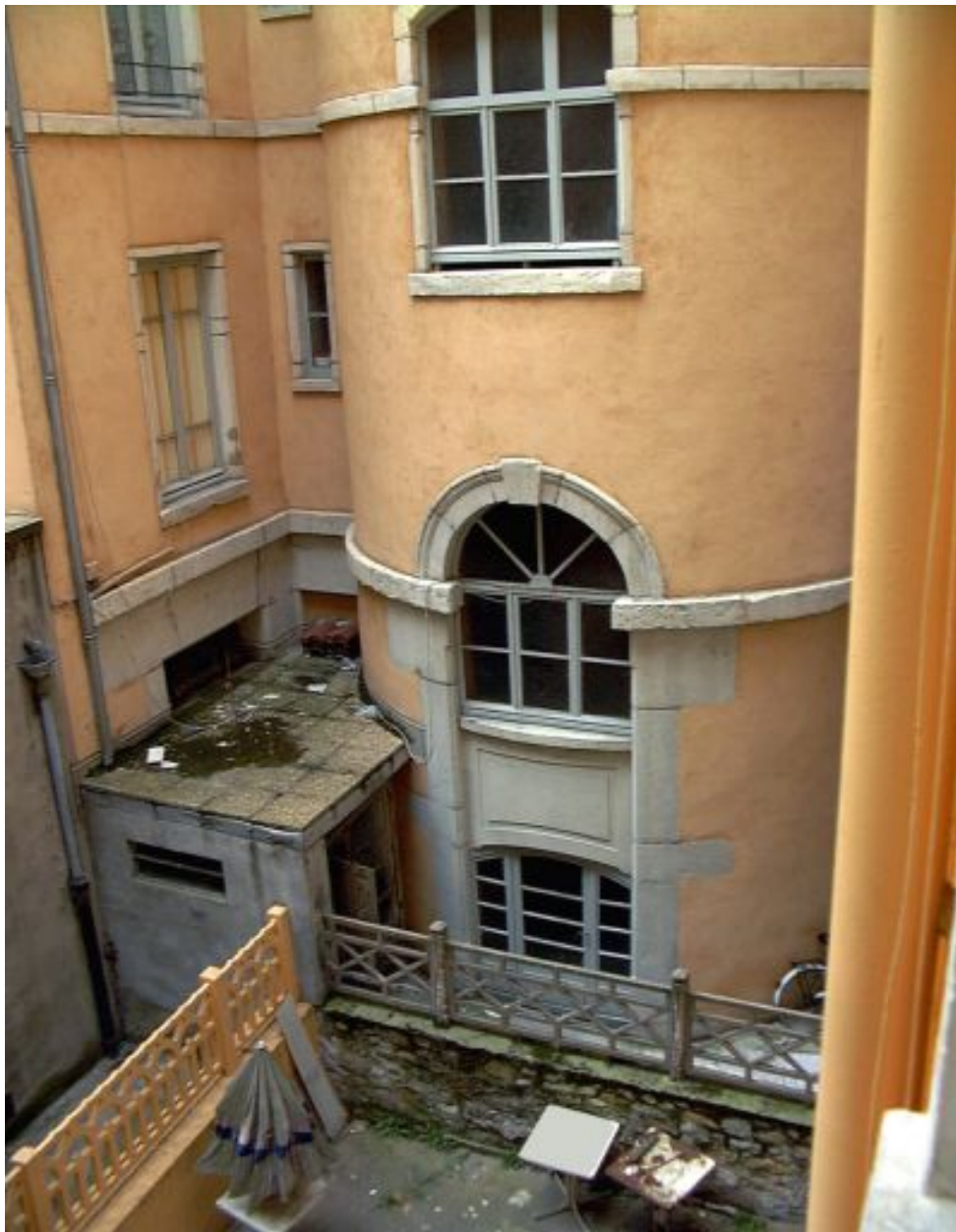
Vue du rez-de-chaussée de la tour d'escalier
