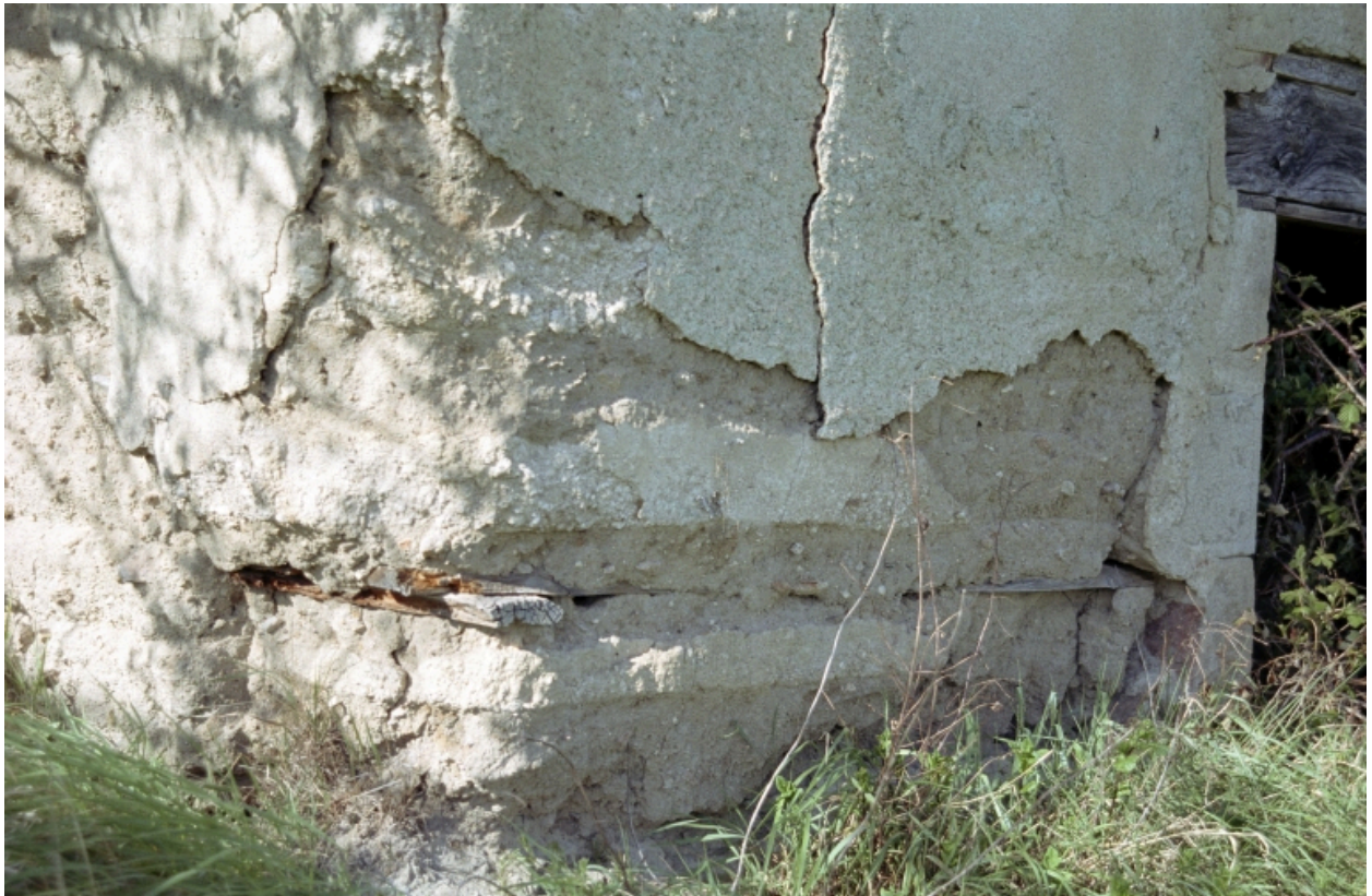
Pralong, Montoisel (1987 A1 259). Loge de type E1b2. Détail d'un angle de maçonnerie en pisé avec renfort de bois.
