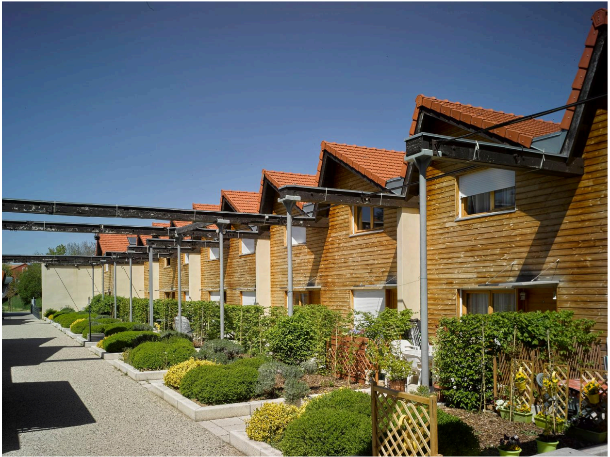
Vue des jardins et des anciennes charpentes métalliques
