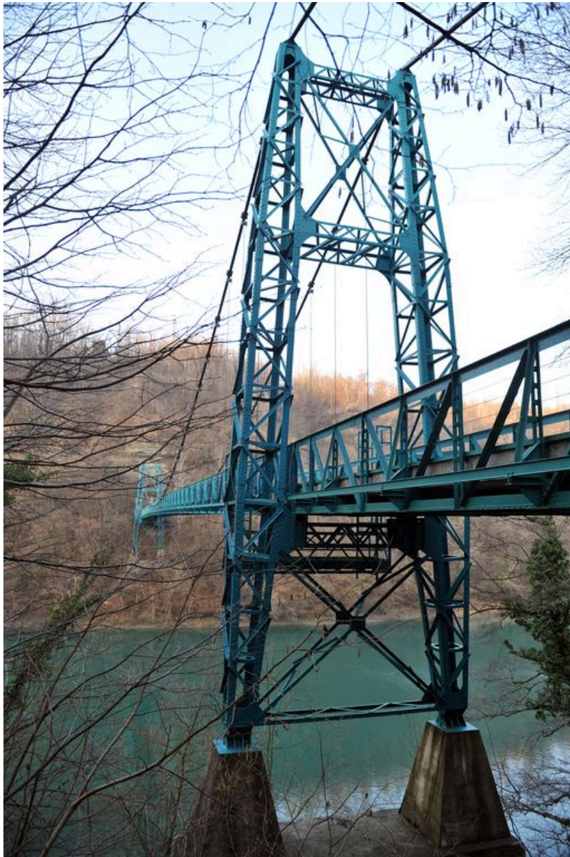
Pylône gauche, parties inférieure et supérieure, vue générale (depuis la rive gauche)
