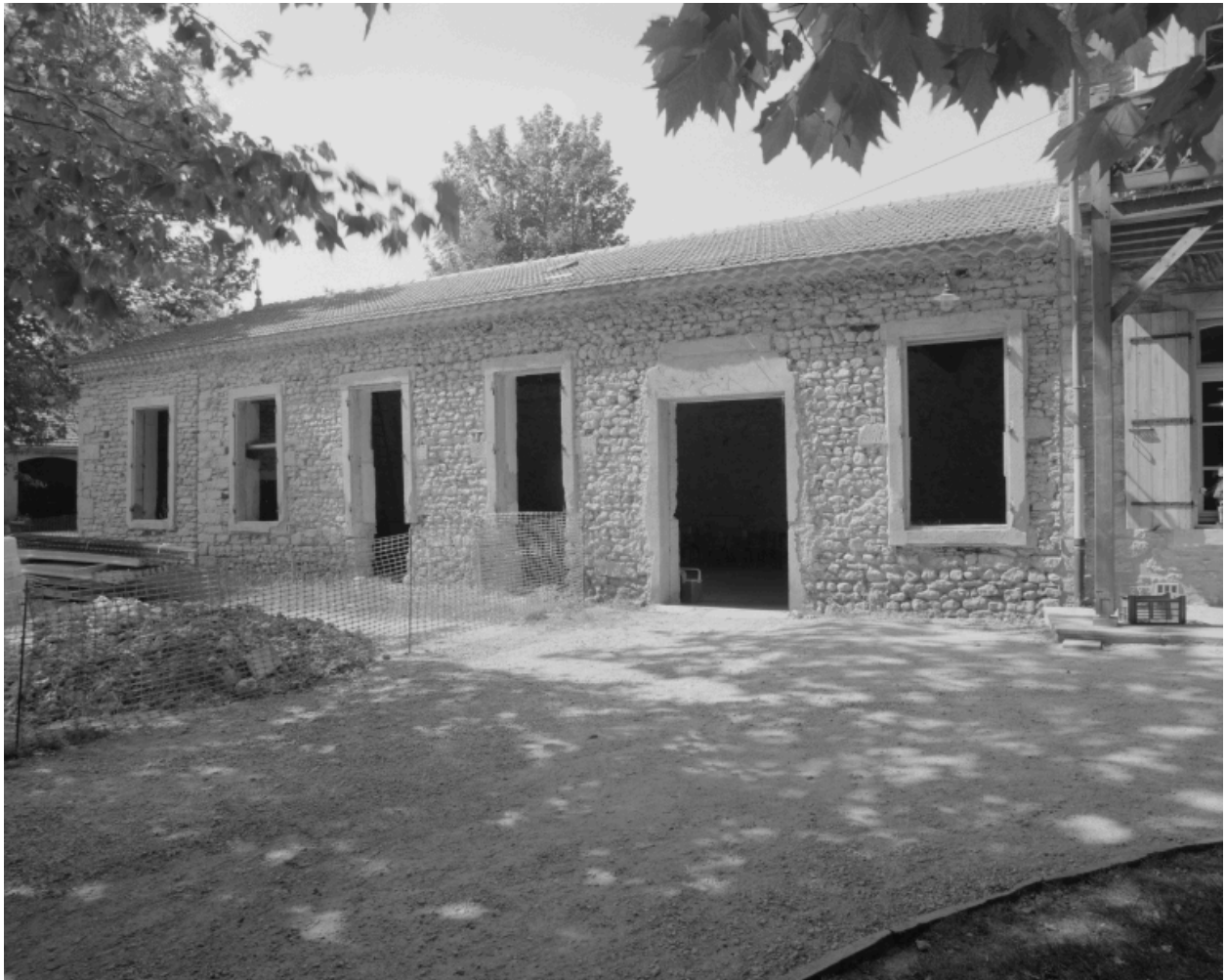
Le Béal. Moulinage, vue d'un ancien atelier.
