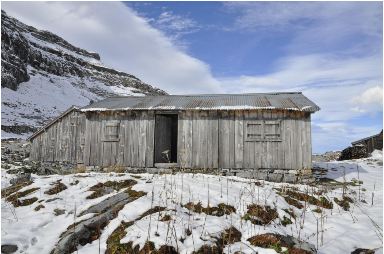
Vue de la façade antérieure sud à la fin de l'hiver
