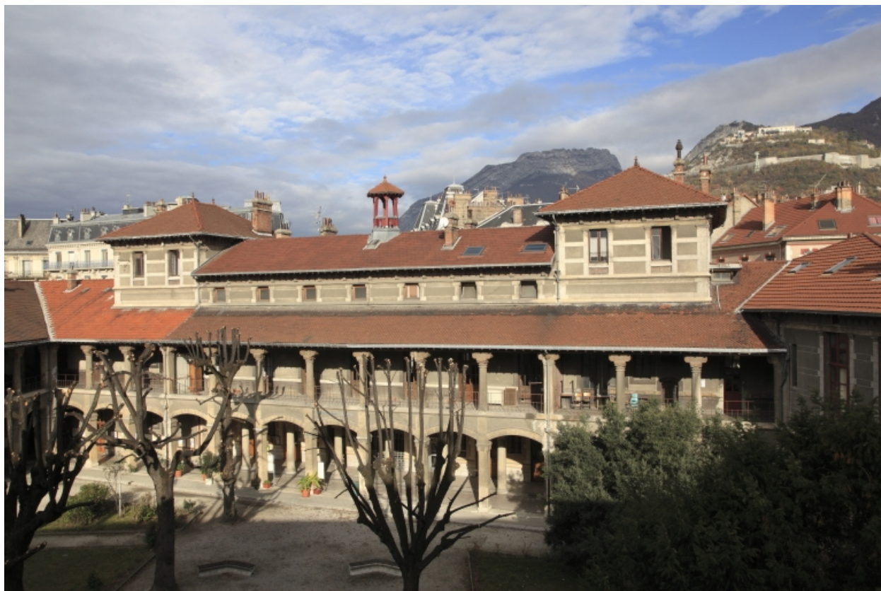
Cour H. Vue d'ensemble du bâtiment d'entrée.
