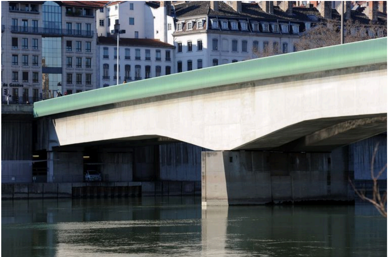
Vue partielle, travée droite, face aval (depuis la rive gauche)
