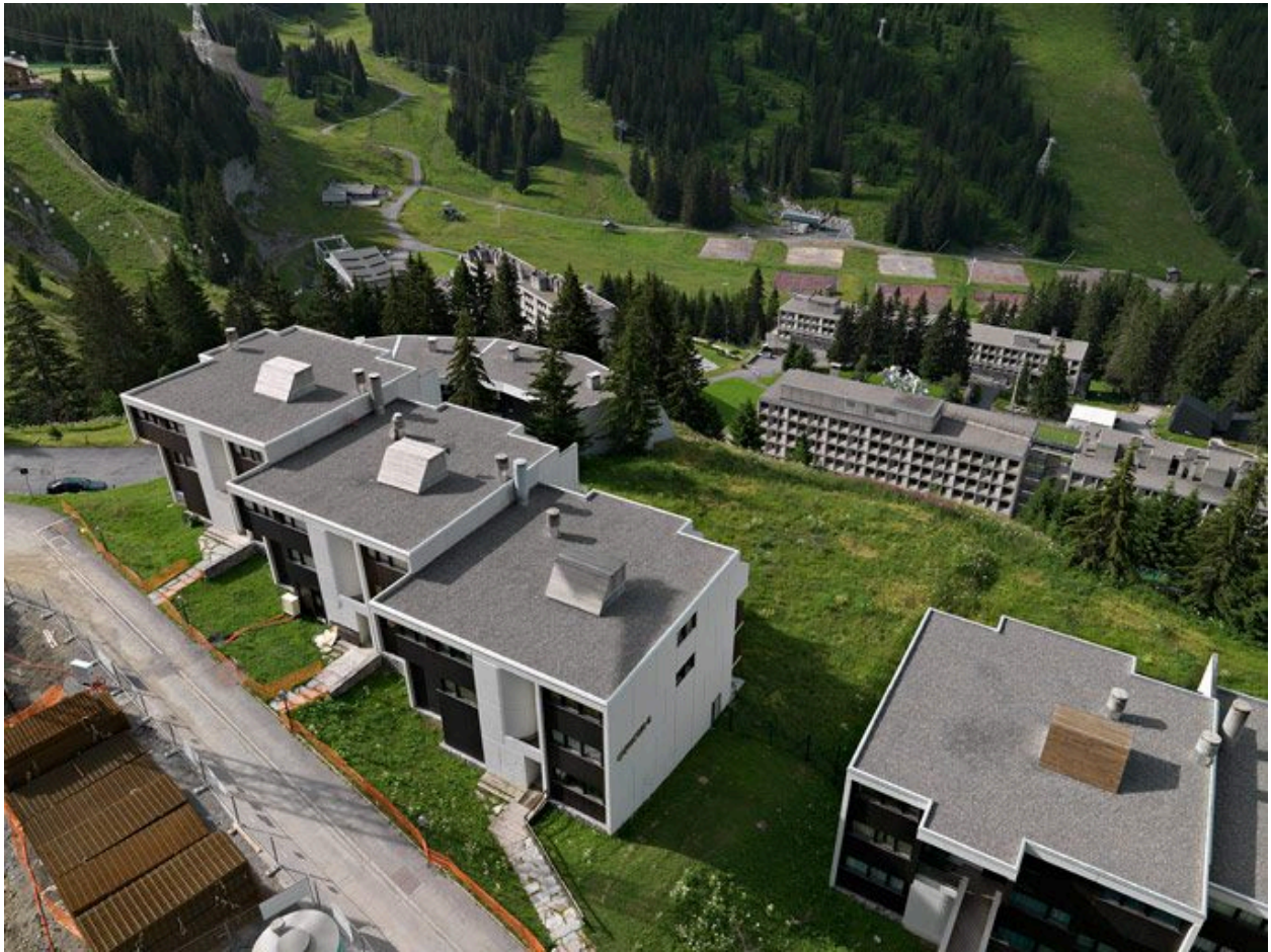
Les toits terrasses
