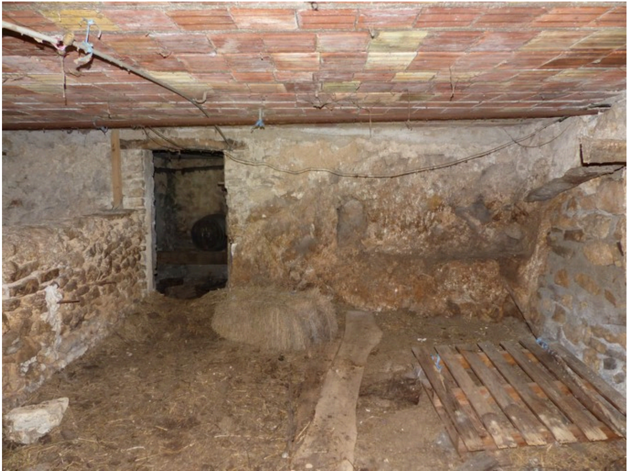
Ensemble occidental. Etage de soubassement, étable sud. Vue de volume prise de l'est.
