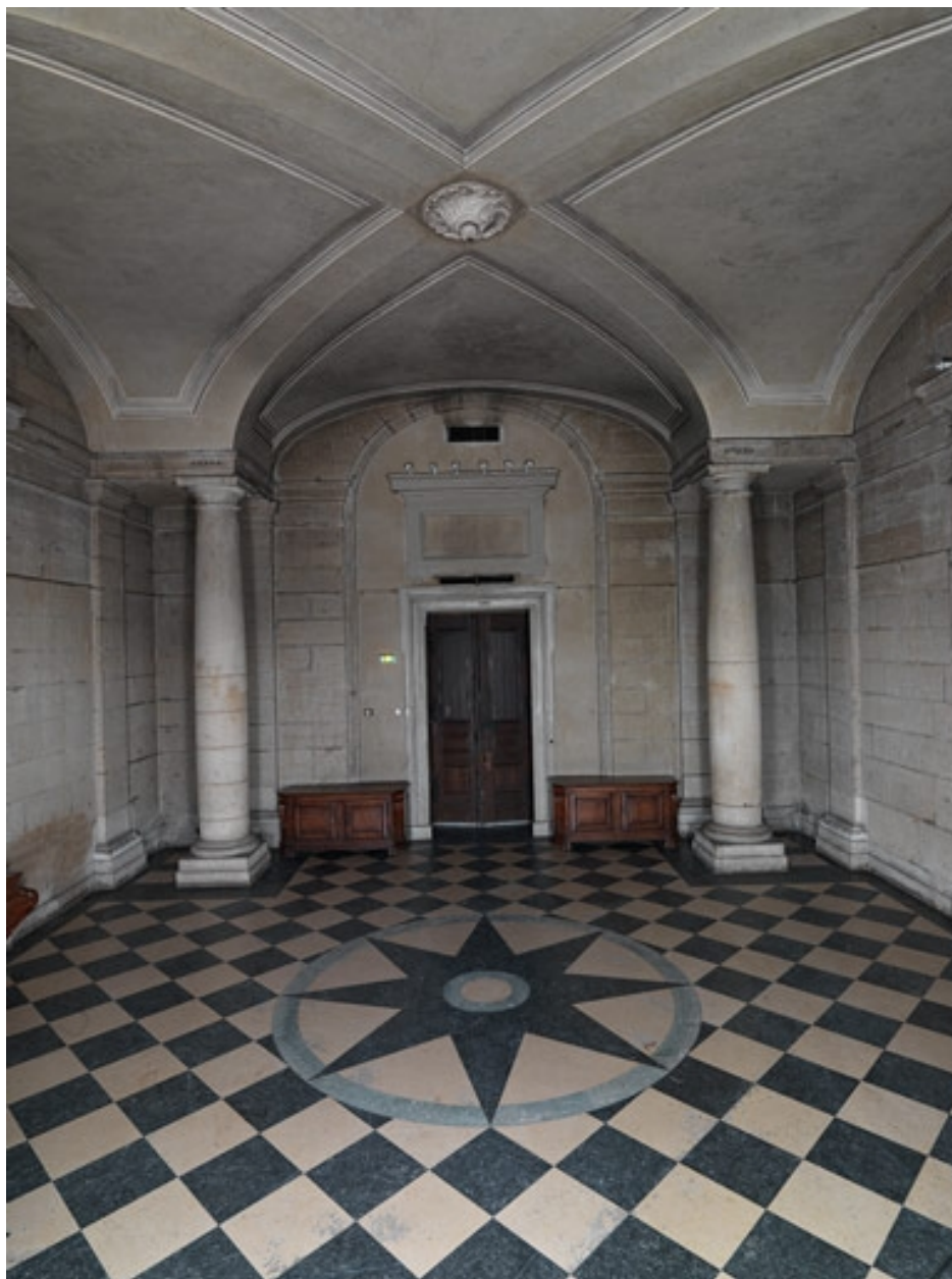
Le dôme Soufflot. Rez-de-chaussée. Vue d'ensemble du vestibule depuis l'est
