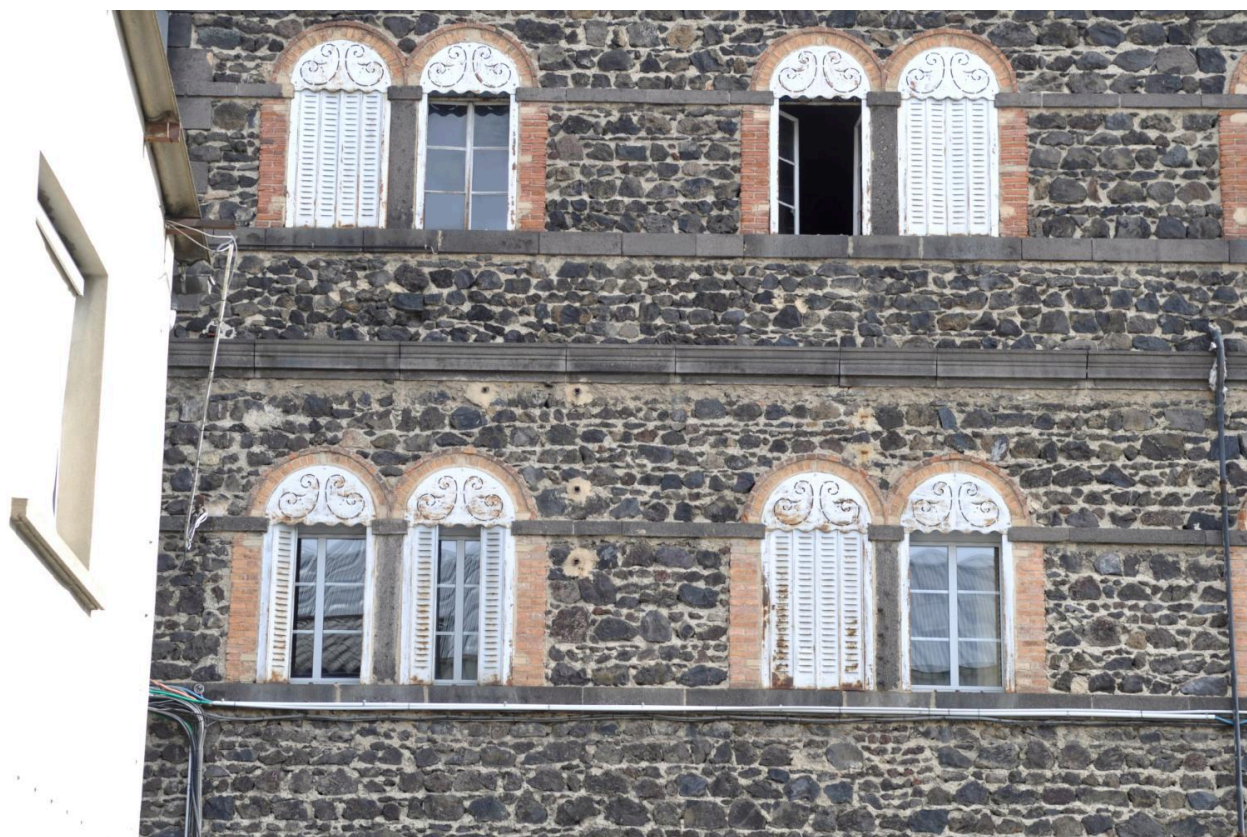
Détail façade de grande qualité
