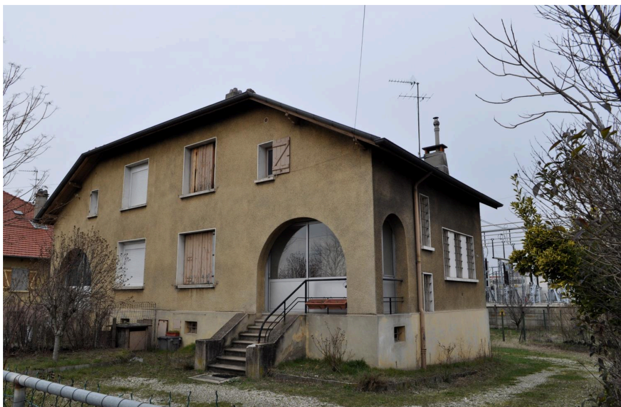
Vue d'extérieur, logements ouvriers, cité EDF
