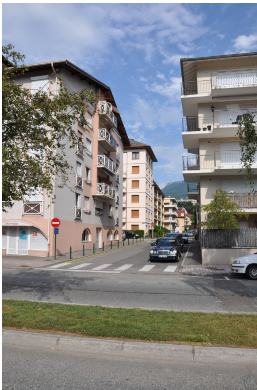
Vue prise depuis l'ouest
