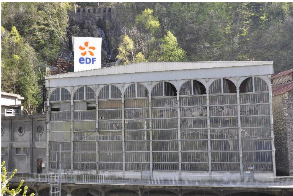
Vue de la facade principale de la centrale de Livet
