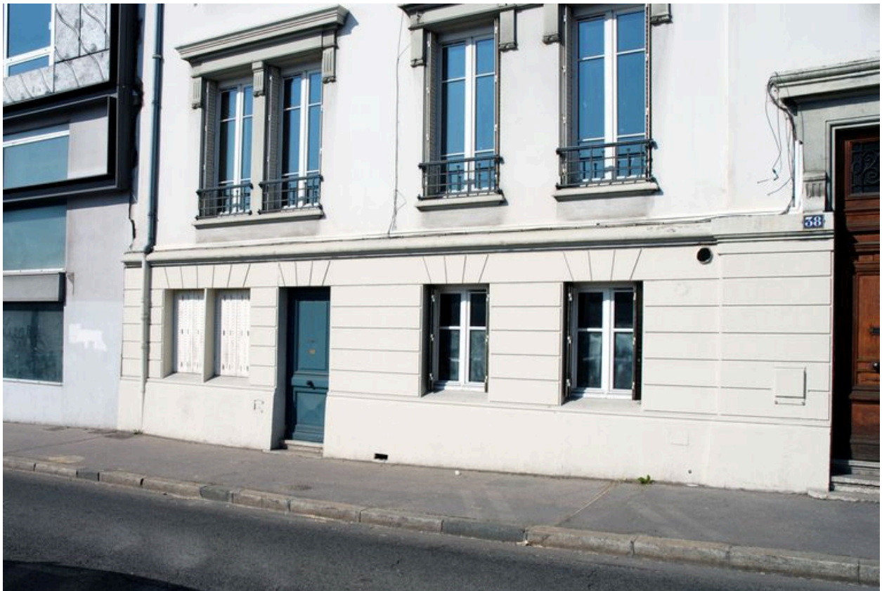
Elévation principale : vue du premier niveau
