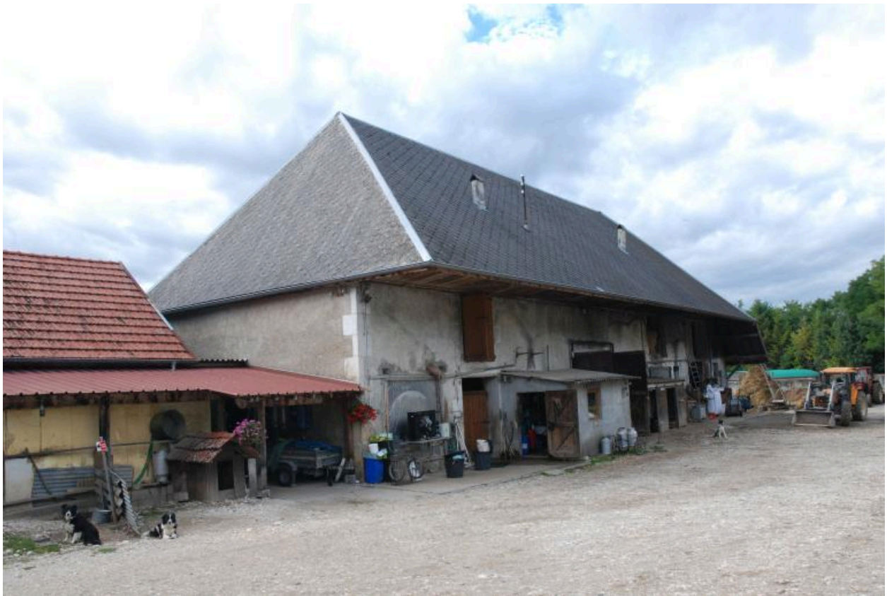
Vue d'ensemble du bâtiment construit vers 1900 comportant des granges-étables
