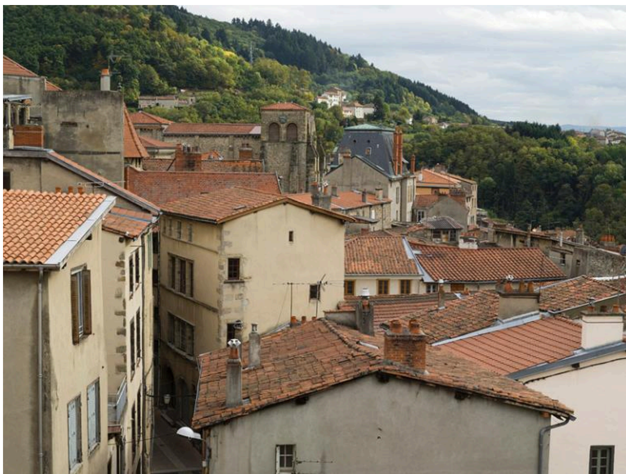
Toits du centre ancien en direction du sud et de l'église Saint-Genès.
