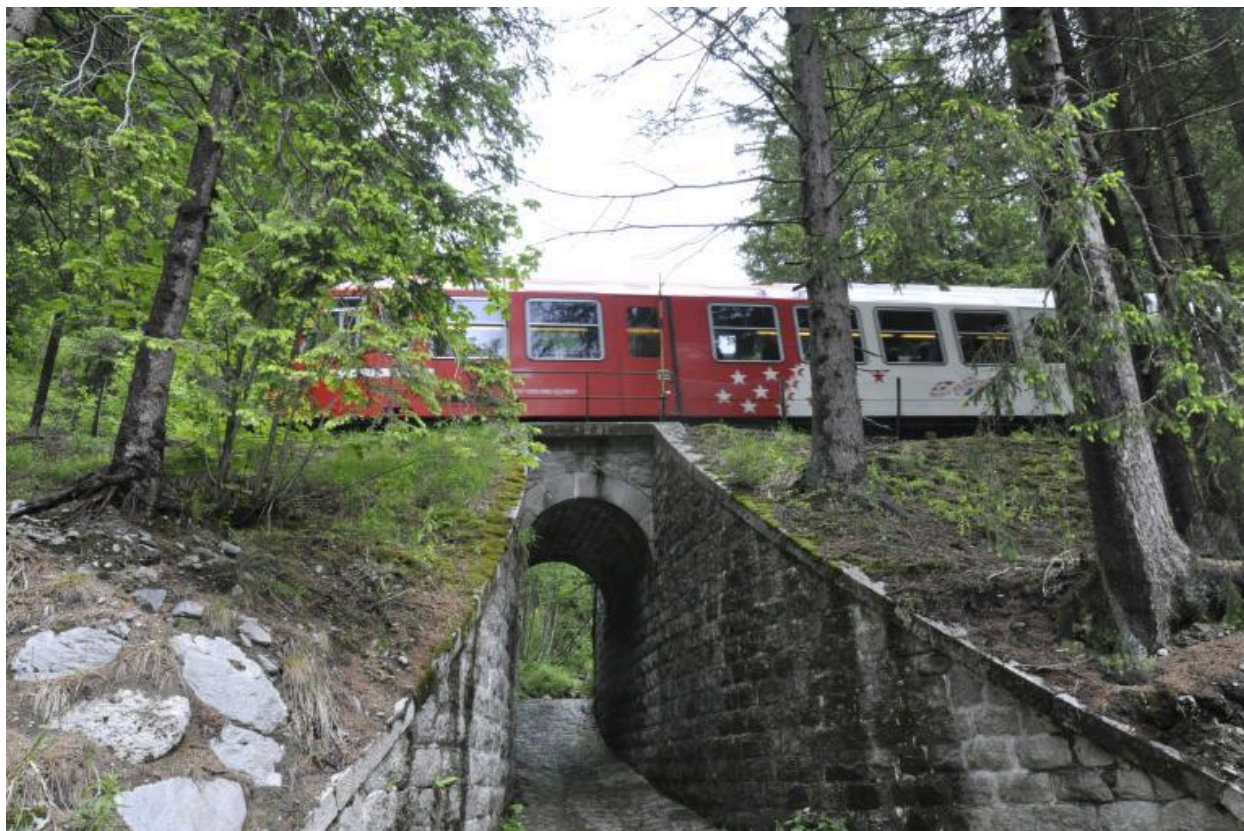
Vue de la face sud-est de l'aqueduc
